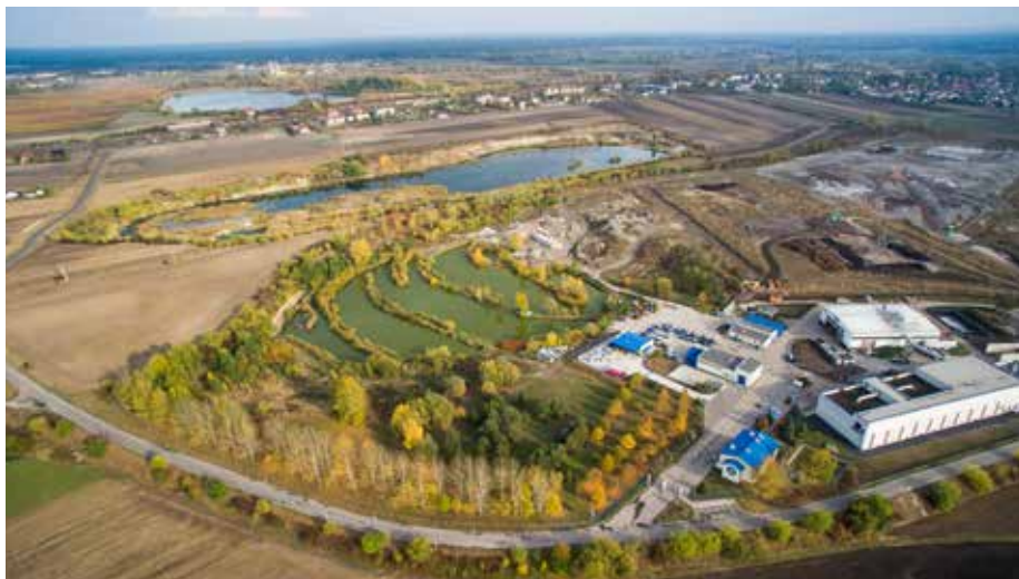
Widok na nieckę składowiska odpadów przy ul. Podmiejskiej 69 w Opolu.
